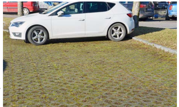
Ansprechend, kostengünstig und versickerungsfähig: eine Stellfläche aus Betonpflaster mit Rasenfuge
