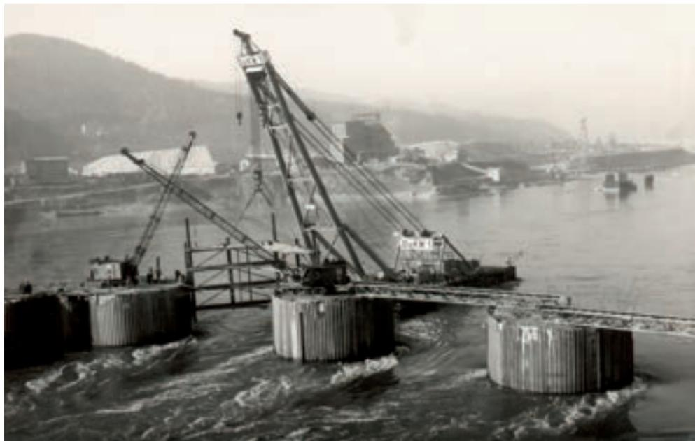
Abb. 3.11 Schwimmkran beim Bau eines Fangdammes in der stark strömenden Donau bei Ybbs-Persenbeug 1957
