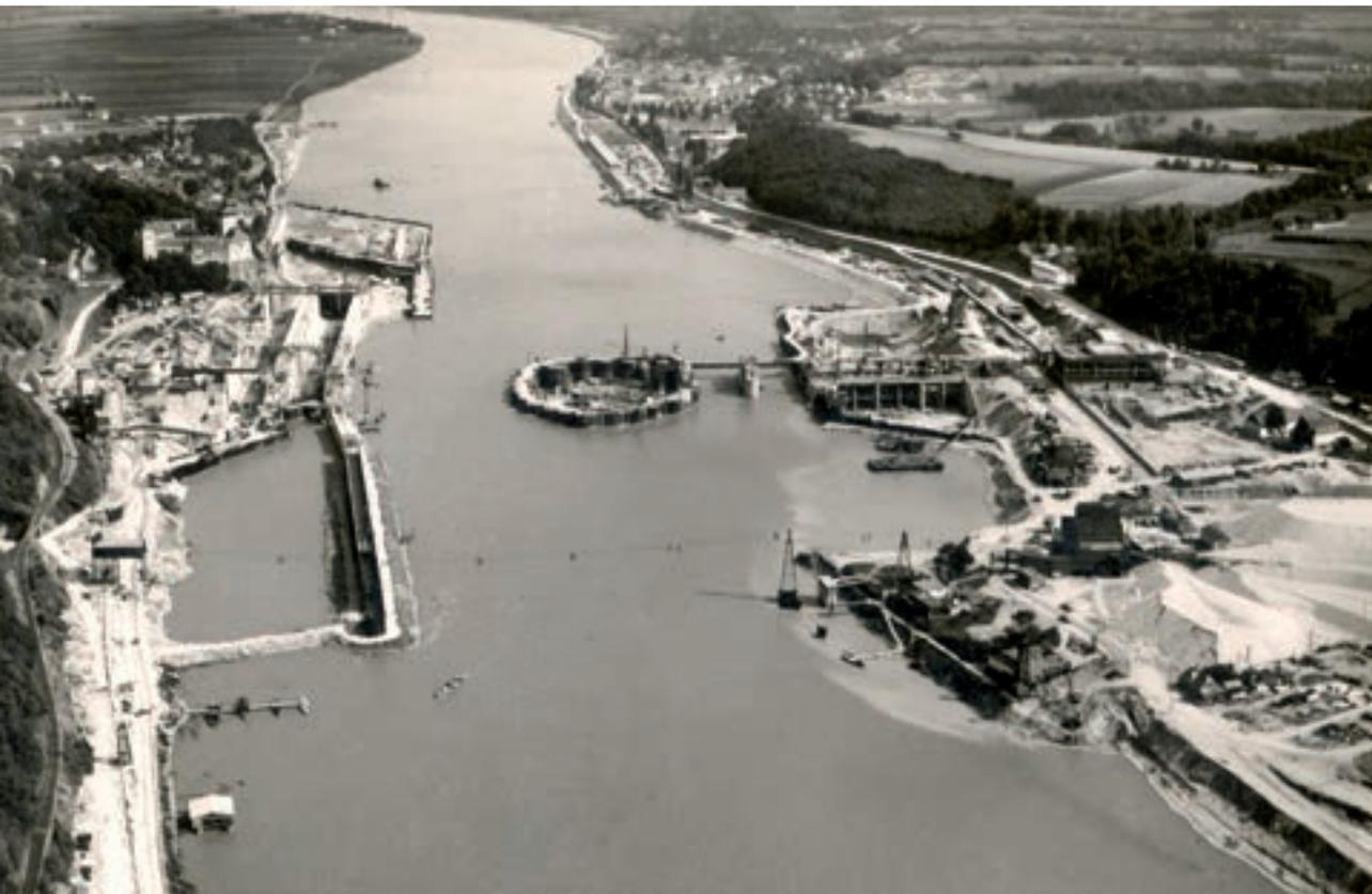
Abb. 3.10 Baustelleneinrichtung zur Errichtung des Kraftwerkes Ybbs-Persenbeug in Nassbauweise 1956
