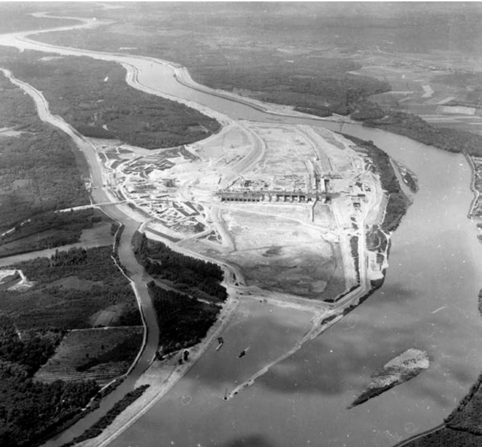
Abb. 3.12 Baugrube des Kraftwerkes Altenwörth kurz vor Fertigstellung im Jahr 1975 donauaufwärts betrachtet. Der ursprüngliche Donaustrom im Bild rechts wurde später zum Altenwörther Altarm. Links unten: Altarm „Weingartlwasser“, über den während der Bauarbeiten die neu umgeleitete Traisen geführt wurde
