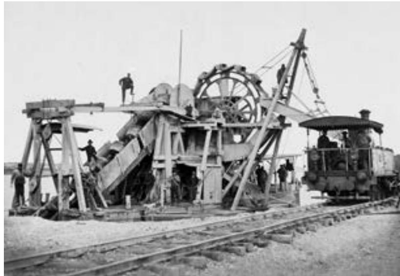
Abb. 2.45 Stationärer Eimerkettenbagger zum Umladen des Kieses von den Transportkähnen auf Loren
