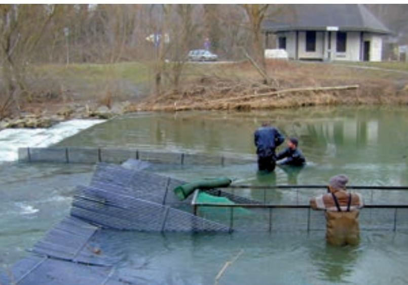
Abb. 4.56 Dynamisches Fischwehr zur Erfassung der Fischwanderung flussauf der Melkrampe
