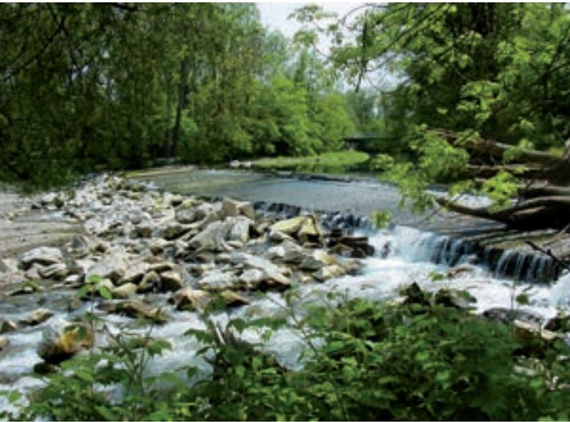
Abb. 3.28 Die unterste Wehranlage der Pielach bei Spielberg (Herrenmühle), die rund 1,6 km flussauf der Mündung in die Donau liegt, wurde bereits im Mittelalter errichtet und blockierte hier bis zur Errichtung einer Fischaufstiegshilfe im Rahmen des Projektes „LIFE-Natur Lebensraum Huchen“ die Wanderung der Fische von der Donau in die Pielach (vgl. Kapitel 4).
