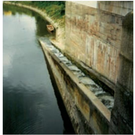
Abb. 2.71 Ansicht des Kraftwerks Kachlet, das im Jahr 1927 als erstes Kraftwerk an der Donau an der bayerisch-österreichischen Grenze in Betrieb genommen wurde. Das rechte Bild zeigt die gleichzeitig gebaute Fischwanderhilfe.
