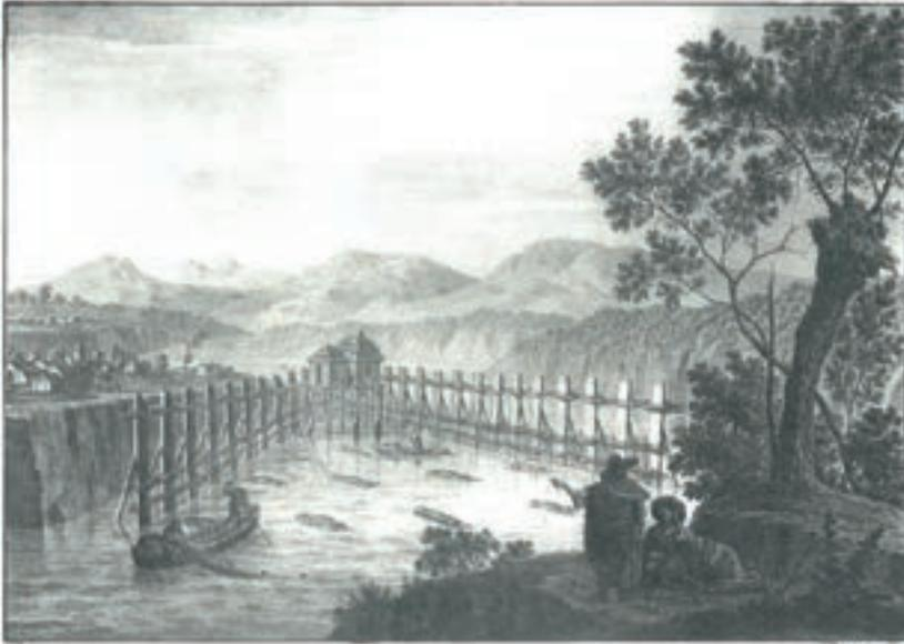
Abb. 1.77 Darstellung von Hausenzäunen in der Sammlung von Donaustichen von Jakob Alt und Ludwig Ermini, circa 1840. Links: Hausenzaun in der wallachischen Tiefebene; darunter: bei Wirbitza. Im Wasser sieht man die Schwimmer, an denen die Fangleinen befestigt waren.
