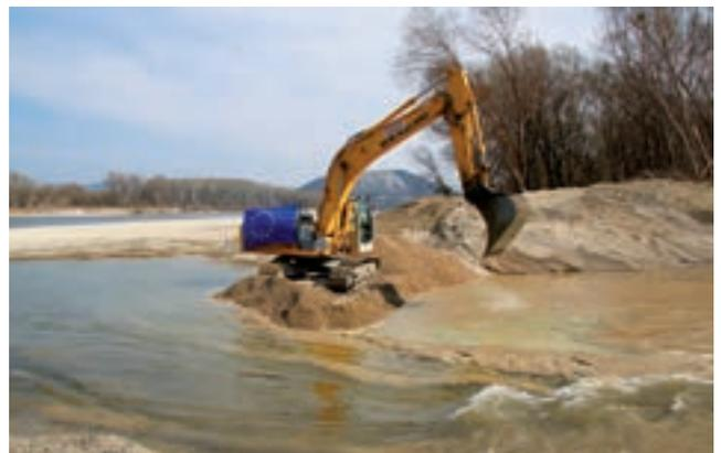
(C) Uferrückbau: Abtrag der Steinsicherungen
