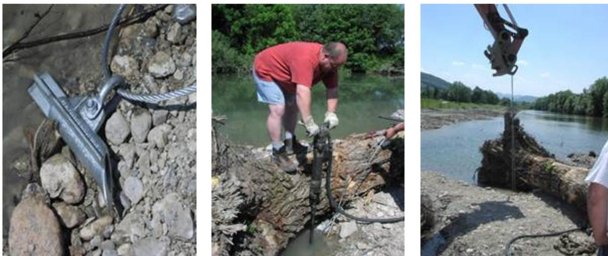
Abb. 6.4: Erdanker mit Stahlseil (D = 10mm) (links), Einbau (Mitte) und Aktivieren (rechts), Fotos: ezb
