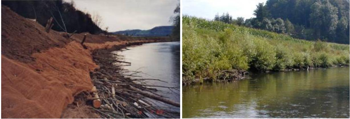
Abb. 5.1: Sulm/Stmk.: Großflächig an den Uferböschungen ausgebrachtes verrottbares Jutenetz zur Sicherung der Böschung gegen Erosion. Am Böschungsfuß wurde zur Strukturierung des Uferbereiches zusätzlich eine raue Spreitlage eingebracht. Links Gewässerabschnitt 2 Jahre nach Fertigstellung der Böschungssicherung. Pfähle und Kokosfasern zersetzen sich im Laufe der Jahre. (Fotos: Baubezirksleitung Leibnitz)
