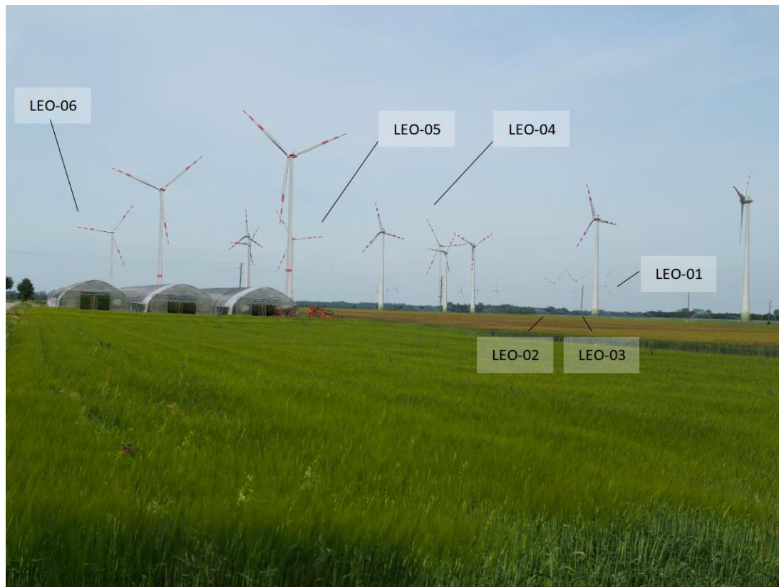
Abbildung 30: Fotomontage FP ANDL 01: 1 Detailplan mit Sichtfeld, 2 Original, 3 Ist-Zustand exkl. gegenständliche Planung, 4 Ist-Zustand inkl. gegenständliche Planung (beschriftet) (Quelle: Einreichoperat, Einlage C.02.02.00-01)
