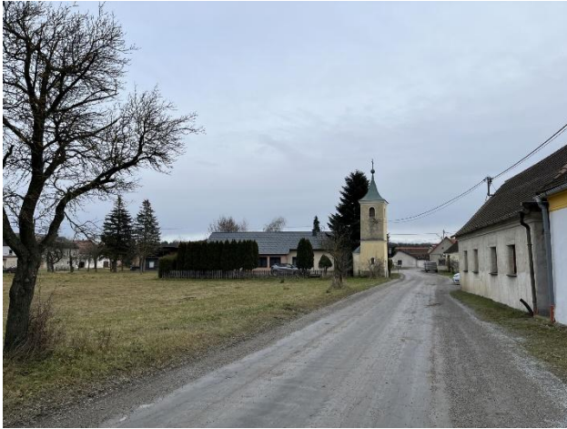
Ortszentrum von Nonnersdorf (eigene Aufnahme)
