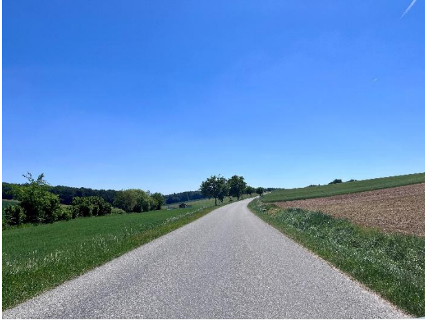
Aufnahmestandort L1198 östlich von Röhrwiesen
