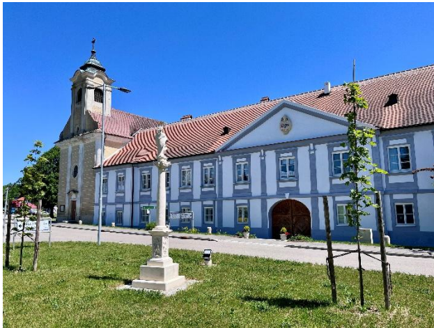
Ortszentrum mit Kirche und Pfarrhof (eigene Aufnahme)
