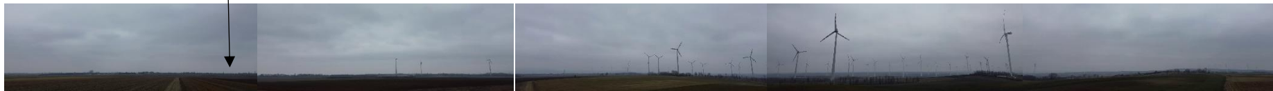
Abbildung 10: 360°- Rundumsicht in 6 m Höhe; Standort IDF-1
