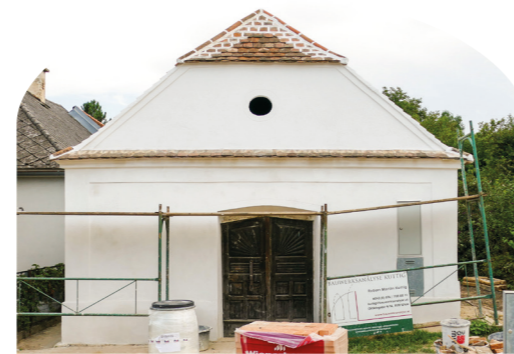
Vorher & Nachher Presshaus in Watzelsdorf
