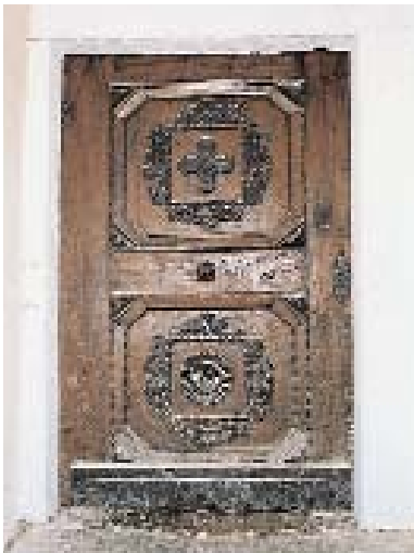
Restaurierte Eingangstür zum Stiegen- aufgang
