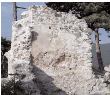
Fertige Musterfläche mit Putz- sicherung
