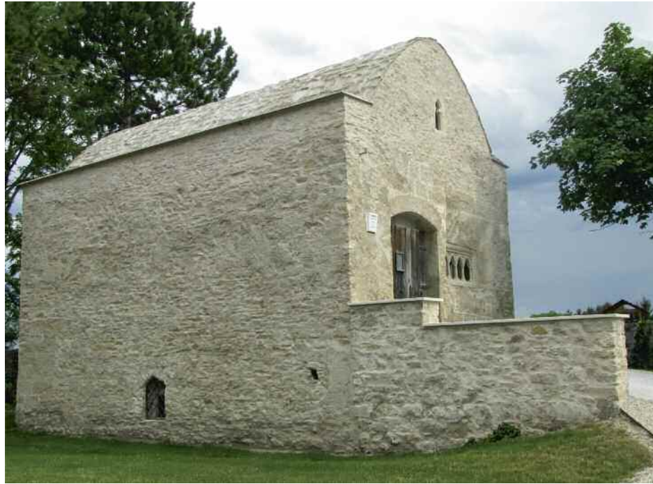
Die restaurierte Fassade des Kärners in St. Margarethen am Moos. Foto ©: Amt der NÖ Landesregierung
