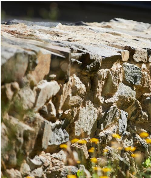
*Mauerkronensanierung: Besonders wichtig ist das Schließen der Fugen und die Wasserableitung von der Krone bis zum Mauerfuß (oben und unten).*
