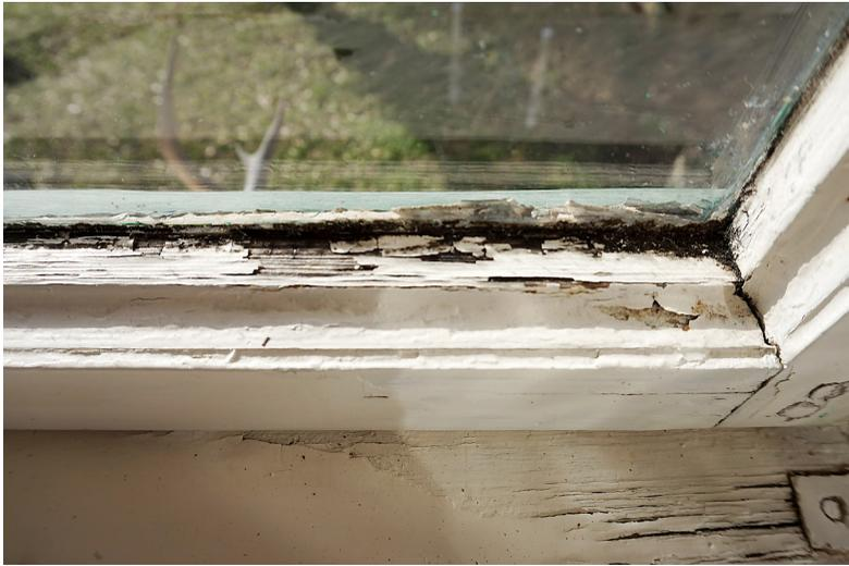
*Vermorschung eines Fensters aufgrund unsachgemäßer Beschichtung*
