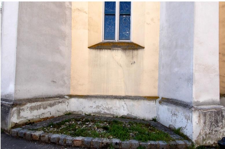
Abdichtungen gegen Feuchtigkeit eingebaut. Deshalb treten häufig aufsteigende Feuchteschäden in der Sockelzone und im Keller auf, die durch Farbveränderung in einer zusammenhängenden Zone erkennbar sind. Weitere Anzeichen sind: Oberflächenverluste der Farbschichten, des Fein- und Grobputzes (je nach Schadensgrad) und bauschädliche Salzausblühungen.
