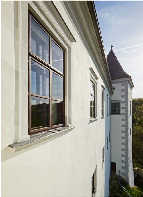
*Kalkputz an der Mauer, Leinölanstrich an den Fenstern und Bleiverblechung: Die Sanierung 2023/2024 erfolgte ausschließlich mit reparaturfähigen Materialien.*
