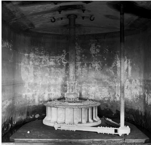
Kraftwerkshalle besteht aus der Francis-Turbine mit stehender Welle und dem Turbinenregler. Die Übersetzung auf die horizontale Welle erfolgte mit einem Kammrad, dessen hölzerne Zähne die Kraft über einen Riementrieb zum Generator weiterleiteten.
