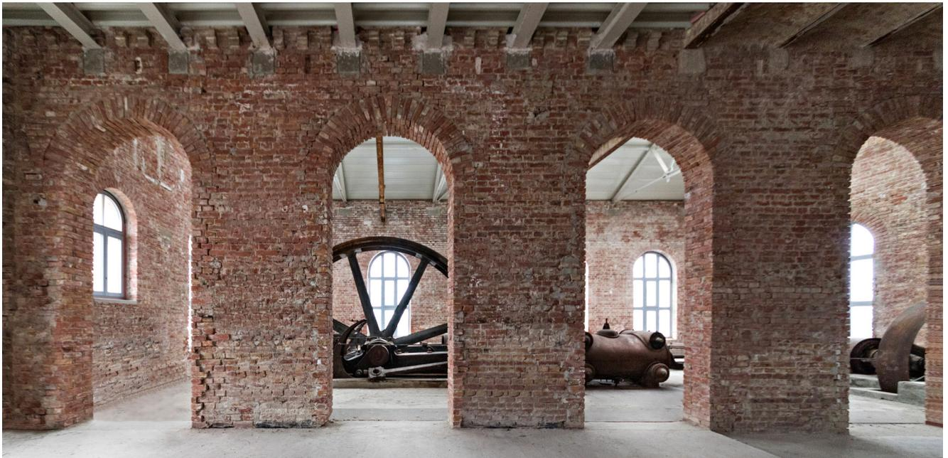
*Maschinenanlage der Bahnwerkszentrale in Simmering. Gut sichtbar ist das zentrale Schwungrad der Dampfmaschinen, das inzwischen nicht mehr zum Antrieb der Transmissionen genutzt, sondern als Generator zur Erzeugung von Drehstrom verwendet wird. Das Kraftwerk gehörte bei Inbetriebnahme zum größten Elektrizitätsversorger Europas.*
