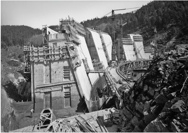
*Bauarbeiten an der Staumauer Dobra 1951: Die Betonierung einzelner Blöcke erleichterte die Ableitung von Hochwässern während des Baus. Bei den Bauarbeiten fanden auch viele Männer aus der lokalen Bevölkerung Arbeit. Diese war schwer und oft gefährlich – auch einige Todesopfer waren zu beklagen.*
