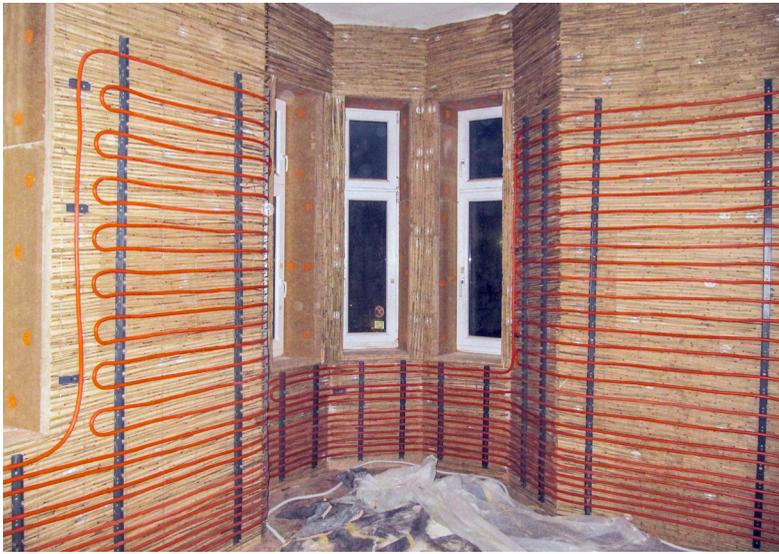
*Horn, Sanierung einer Gründerzeitvilla aus 1898, Innenwände wurden mit Holzweichfaserplatten gedämmt, darauf wurden eine Schilfstuckatur, ein Wandheizungsregister und zwei Lagen DIN-Norm konformer Lehmputz aufgebracht.*
