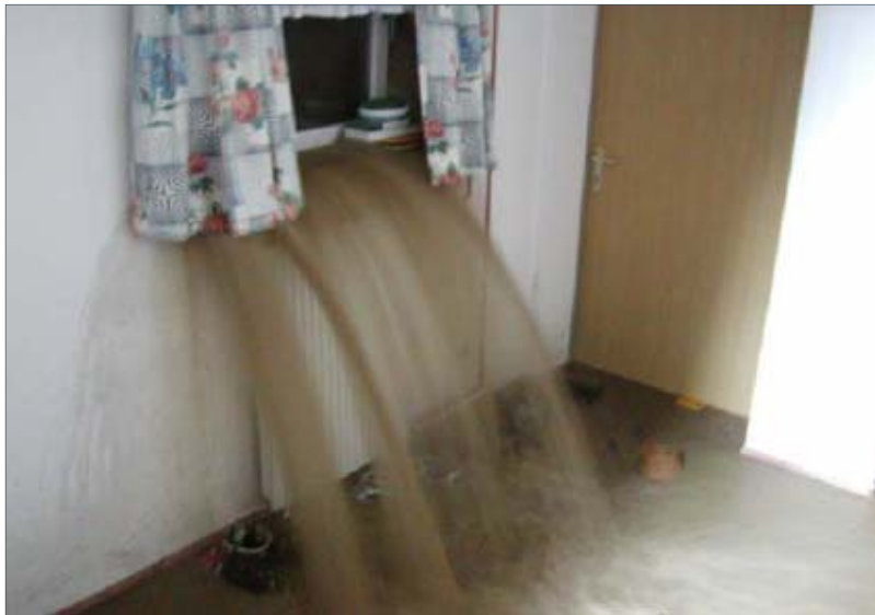
Wassereintritt an der Verbindung Fensterstock zu Mauerwerk
