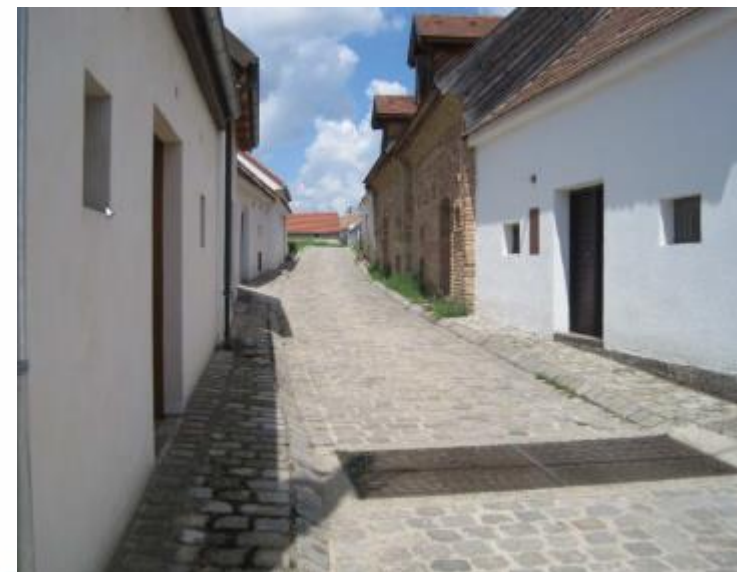
Silniční koryta a obruby
