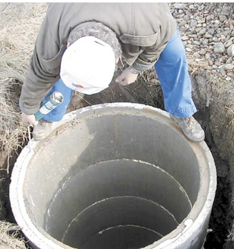
So nicht! Brunnenringe falsch gesetzt, flexiblen Fliesenkleber verwenden!
