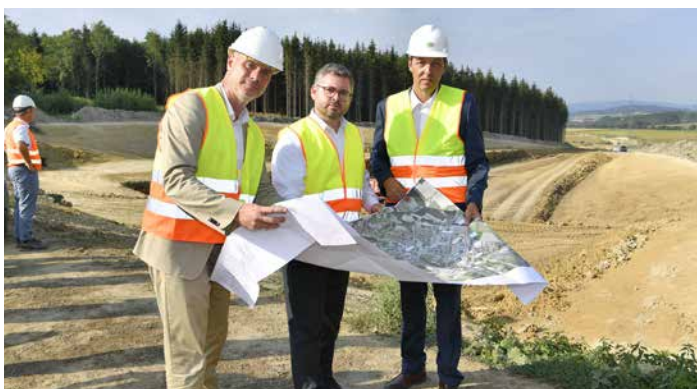
Lokalausweis an der neuen Umfahrung Wieselburg: Landesrat Ludwig Schleritzko, flankiert von NÖ Straßenbaudirektor Josef Decker (rechts) und Projektleiter Wolfgang Leitgöb (links).
