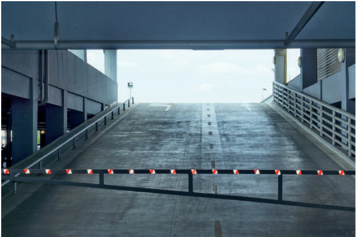
Abb. 43: Aufhellung gegenüberliegender Wohnräume durch das Kfz-Scheinwerferlicht bei der Ausfahrt
