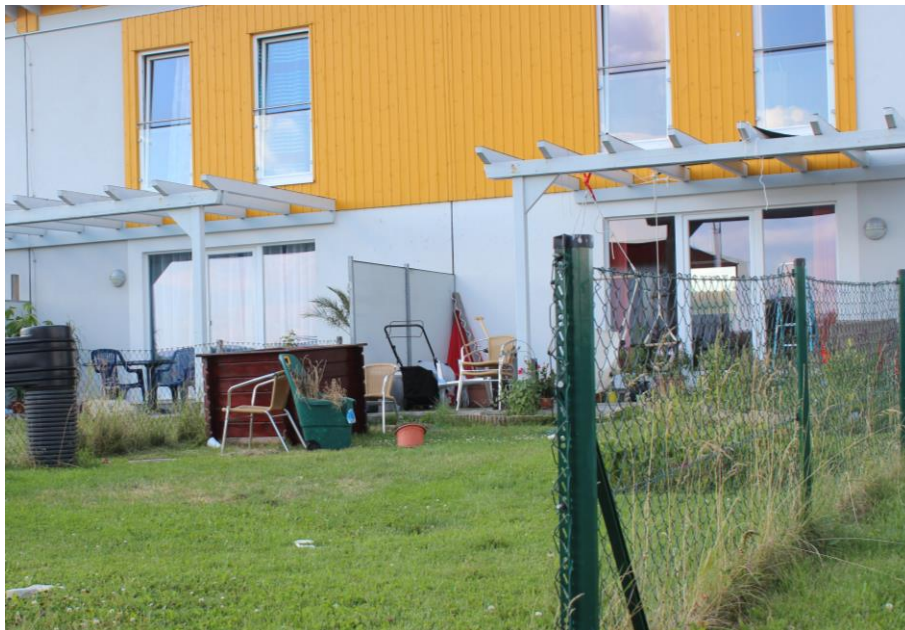
Abbildung 30: Wohnhäuser in der Wohnhausanlage Echsenbach Sonnenhangstraße (Bildquelle: B-NK)
