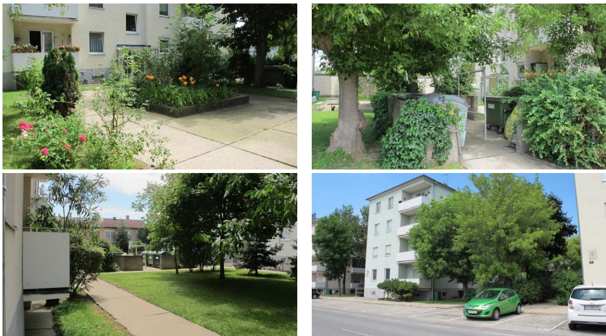
Abbildung 26, 27, 28 und 29: Wohnhausanlage Stockerau Grafendorferstraße (Bildquelle: B-NK)
