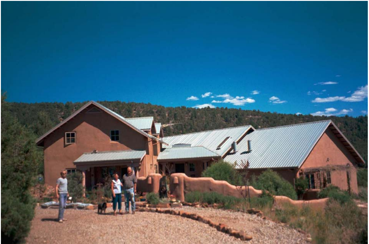
Abbildung 3: Strohhaus von Jack Martin, östlich von Santa Fe
