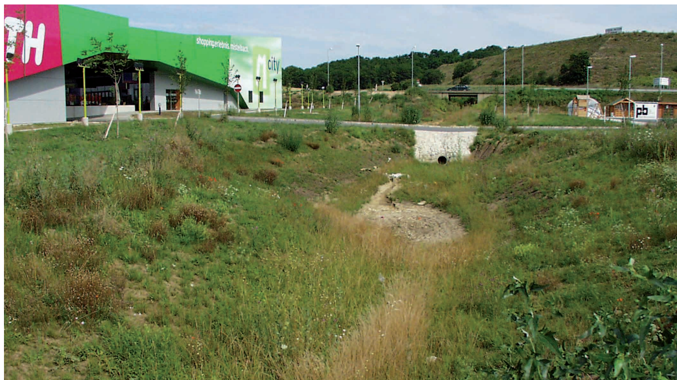
Abb. 27: Extensiv gepflegte Retentionsmulde in Mistelbach
