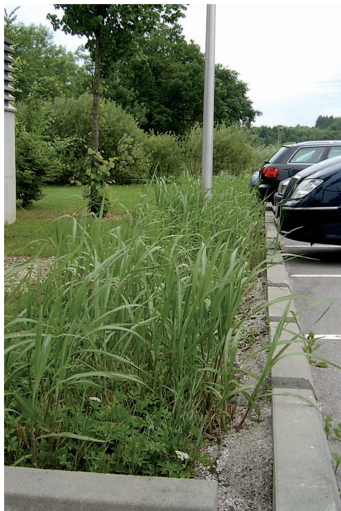
Abb. 17: Mit Röhricht bewachsener Sickergraben
