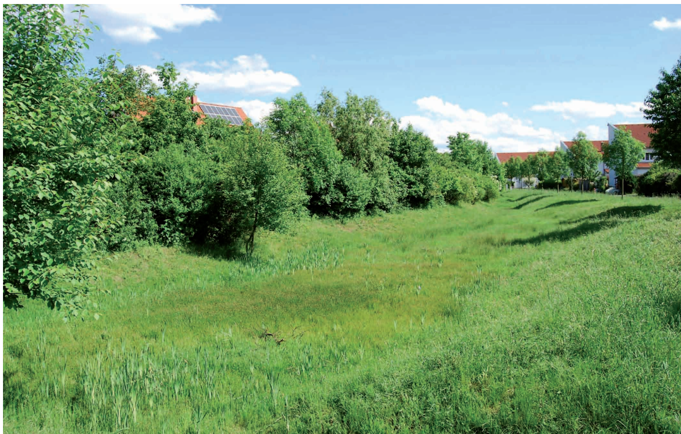
Abb. 3: Beispiel naturnaher Oberflächenentwässerung im Ortsteil Büchenbach, Erlangen
