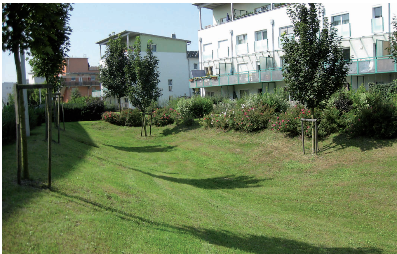
Abb. 26: Intensiv gepflegte Versickerungsmulde in SolarCity Pichling, Linz
