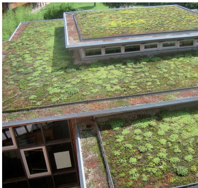
Abb. 19: Flachdächer, die als Gründächer ausgeführt werden, führen zu einer Reduktion des Niederschlagsabflusses.
