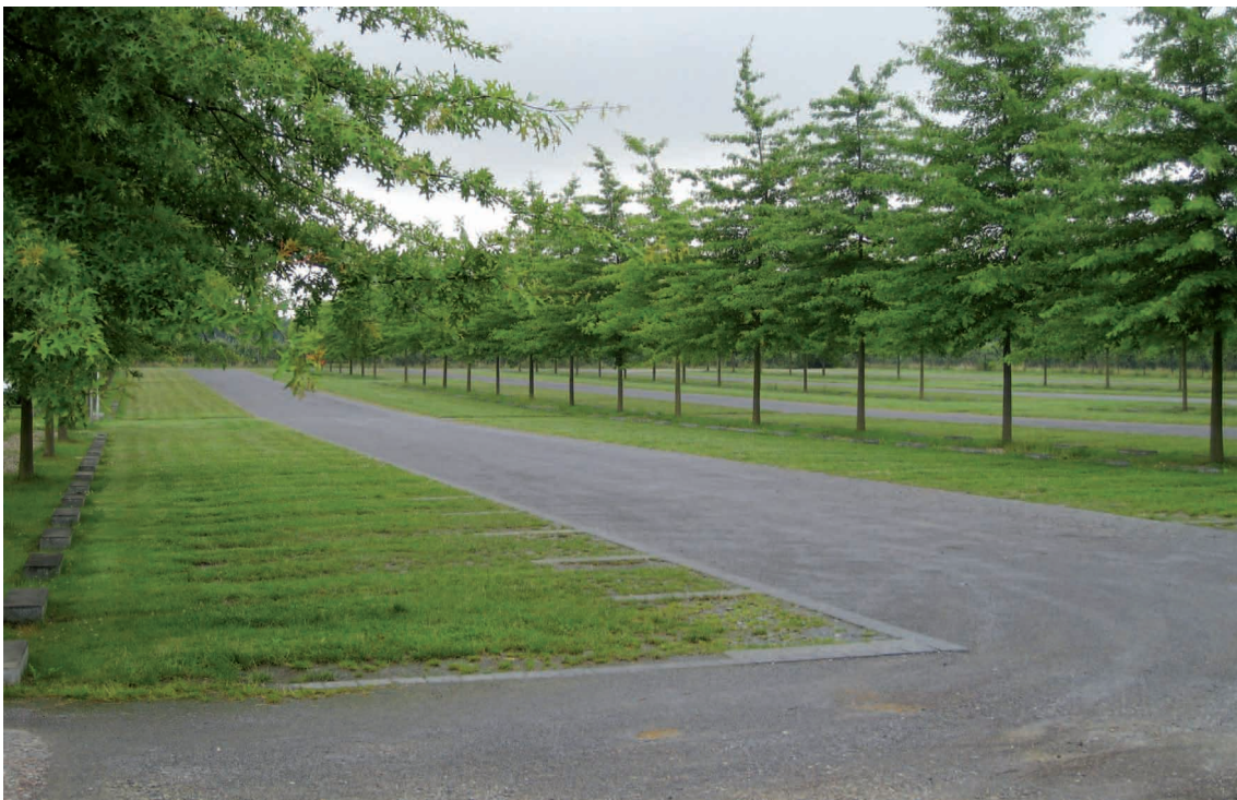
Abb. 21: Parkplätze mit Schotterterrassen
