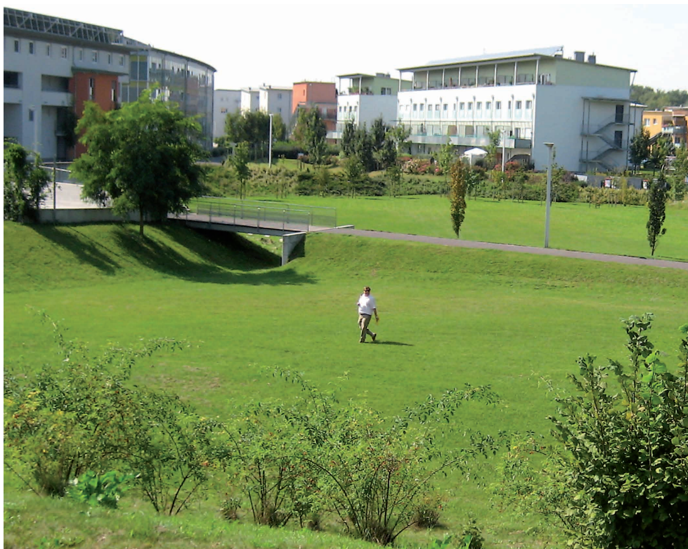
Abb. 6: Als Freiflächen genutzte Retentions- bzw. Versickerungsmulden in SolarCity Pichling, Linz
