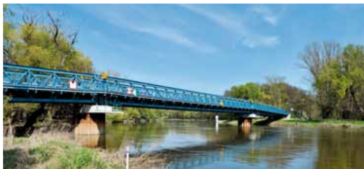
Brücke über die March
