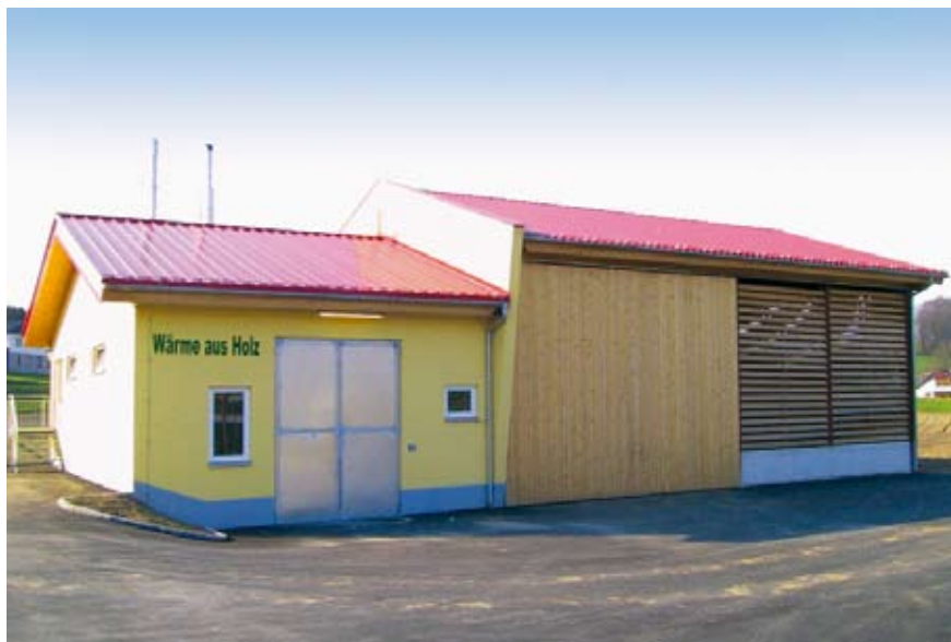
Biomasse Fernheizwerk Vestenthal
