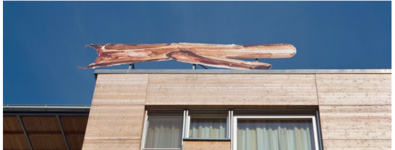
Siggi Hofer „Treibholz“ Skulptur für das Dach des LPH Wallsee, 2005
