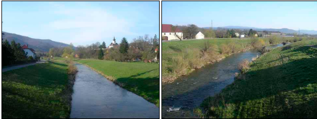
Abb. 14: Melk, Brücke bei Matzleinsdorf; Strukturarmut im Gewässer
