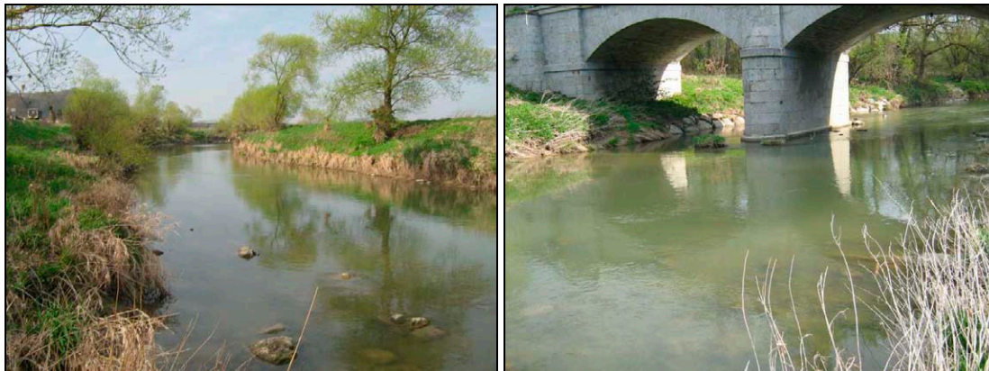
Abb. 15: Brücke bei Winden
