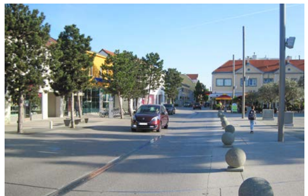
Abbildung 15: Abgrenzung der Fahrfläche durch Betonkugeln (Leobersdorf, Hauptstraße)
