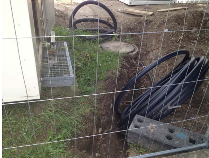
Abbildung 2: Baustelle neben der Luftgütemessstelle Krems
