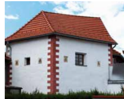
„Roter Turm“ mit römischen Fundamenten in Mautern
