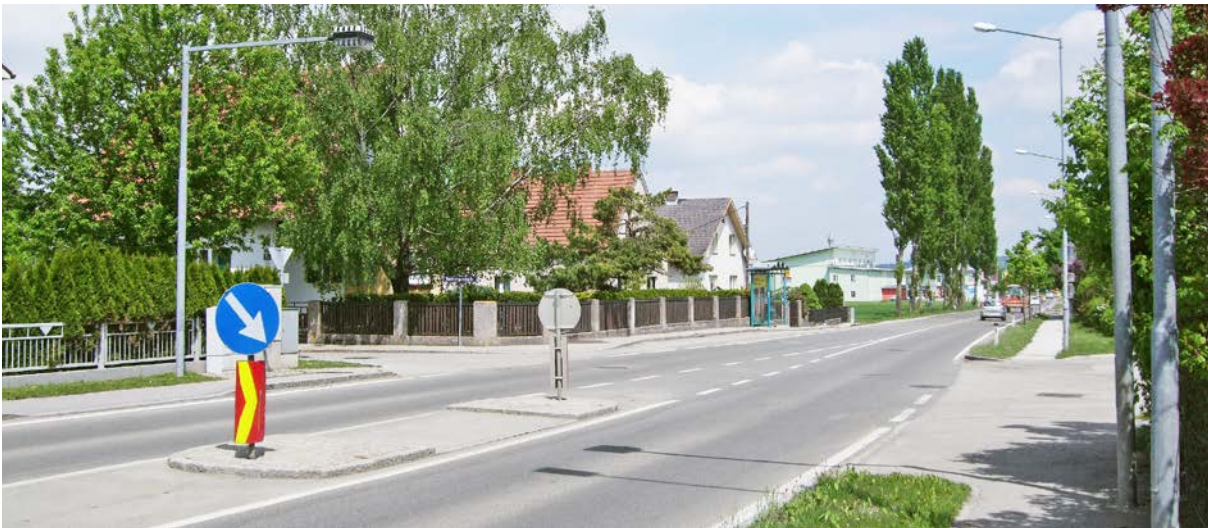
Abbildung 33: Beispiel für Fahrbahnteiler; St. Pölten, B1
