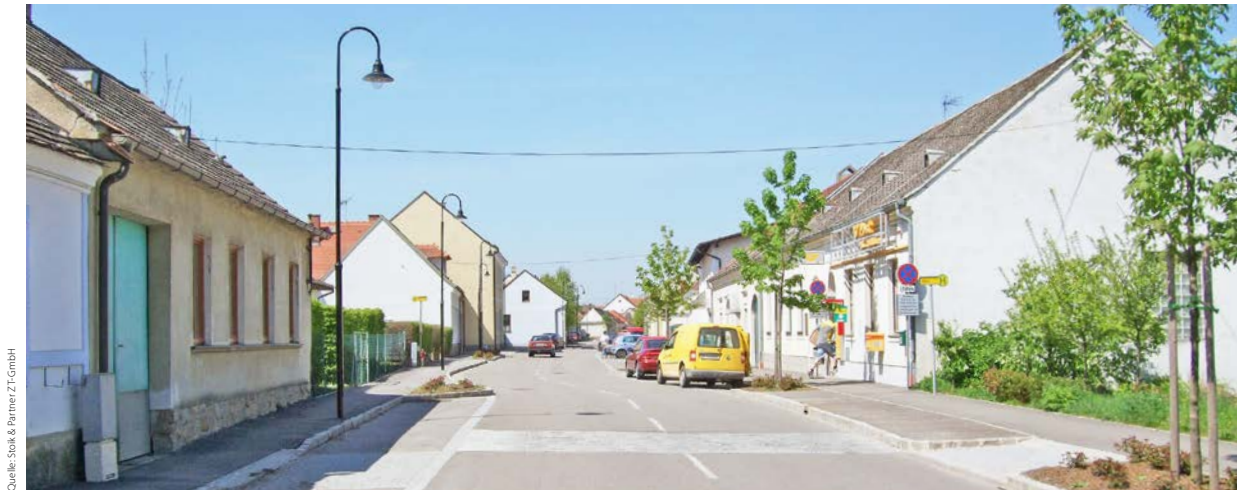
Abbildung 31: Beispiel für Fahrbahnversatz; Nappersdorf, L35
