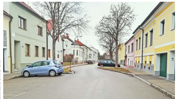
Abbildung 32: Beispiel für Fahrbahnversatz; Hollabrunn, Rapfstraße
