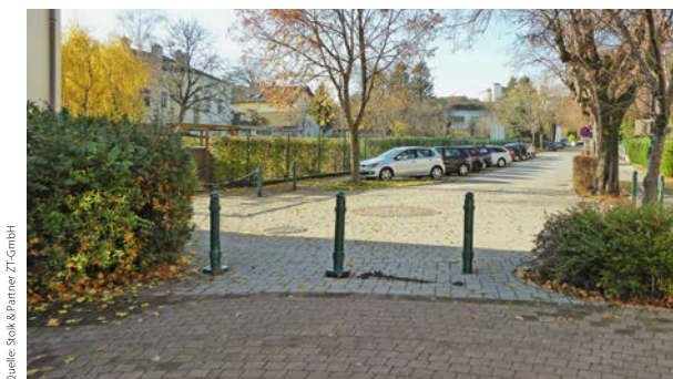
Abbildung 29: Beispiel für Sperre; Bad Vöslau, Raulestraße
