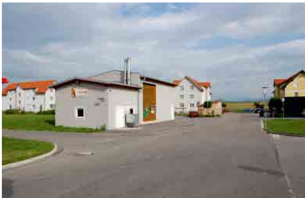
Biomasse-Nahwärmanlage Groß Sierning zur Wärmeversorgung einer Wohnhausanlage; Quelle:Josef Petschko
